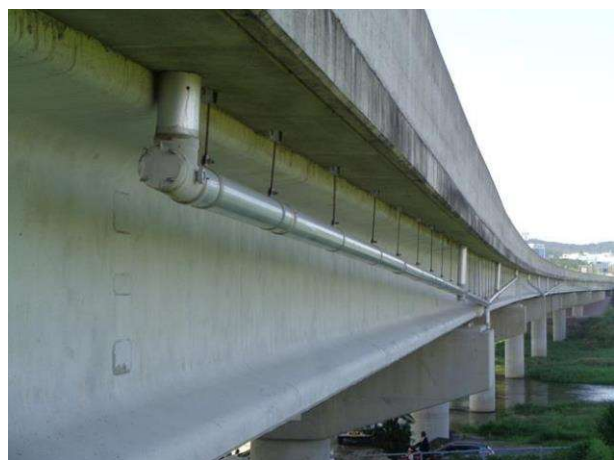
10공구 산하교 (10공구)
