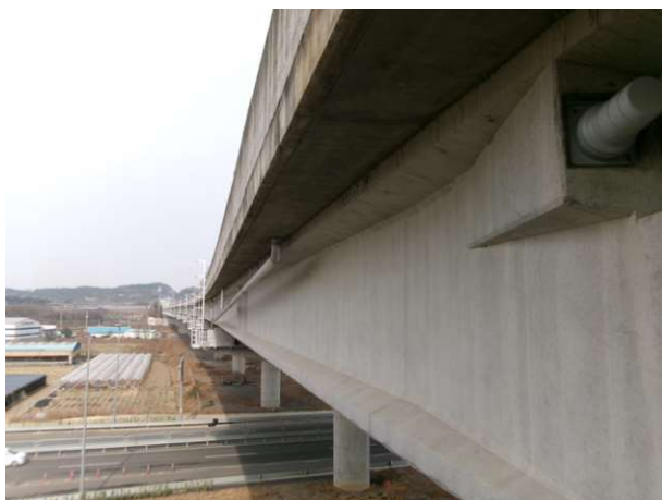
9공구 고현천교 (9공구)
