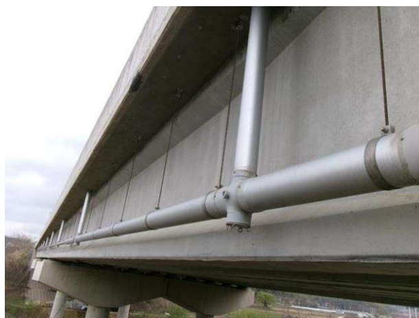
2공구 월가교 (2공구)
