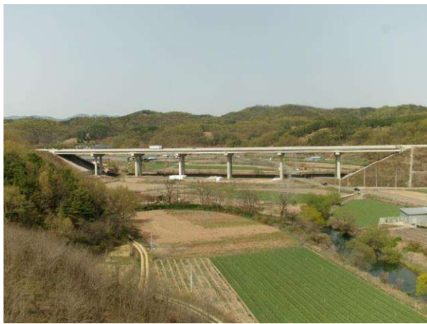
9공구 가래실교 (9공구)
