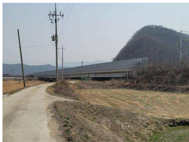
6공구 금매교 (6공구)
