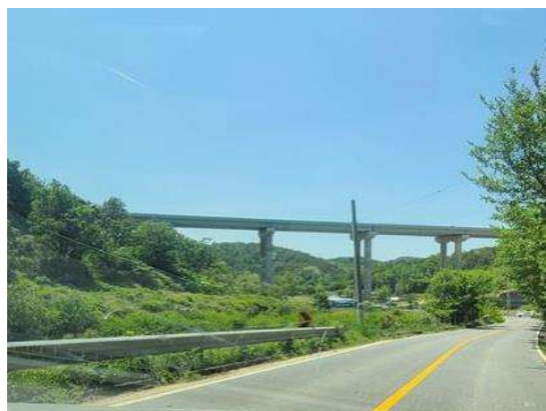
5공구 오실교 (5공구)
