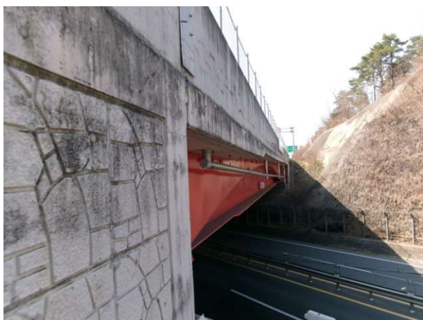
9공구 오미교 (9공구)
