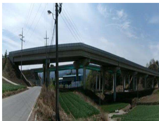
8공구 가천교 (8공구)
