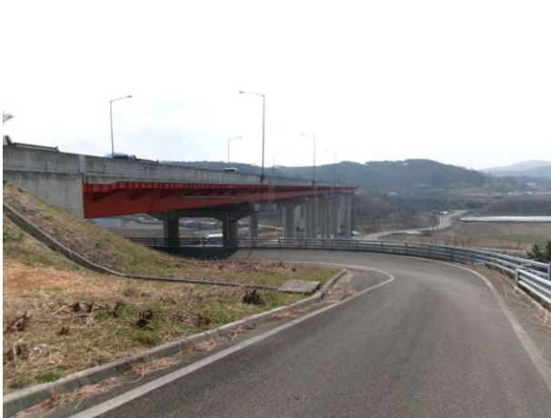
8공구 화산JCT RAMP-A1교(8공구)
