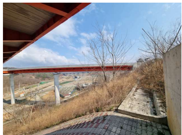
8공구 화산JCT RAMP-H교(8공구)
