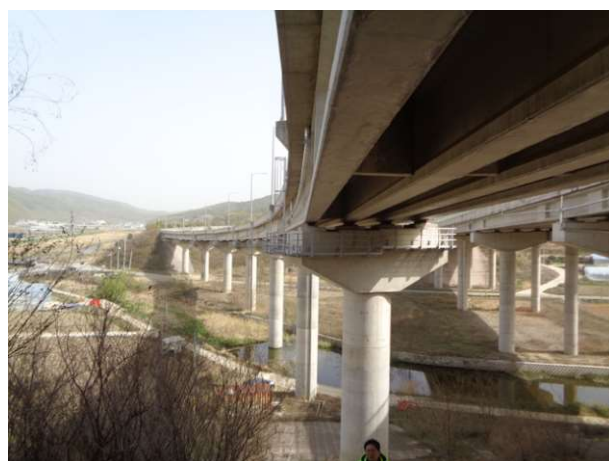
5공구 군위JCT R-C교 (5공구)
