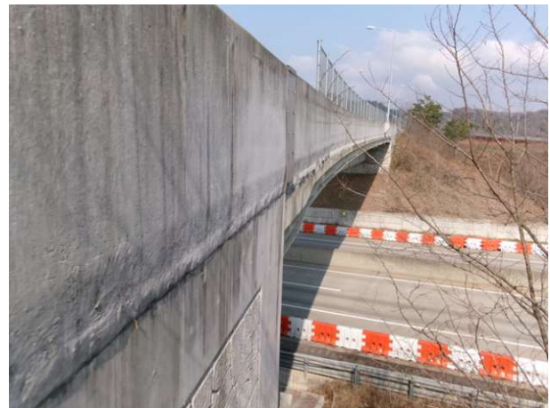
8공구 화산JCT RAMP-A교(8공구)
