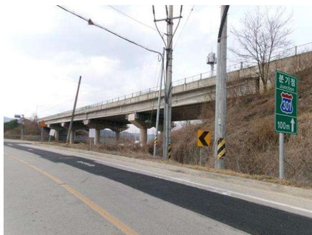
3공구 신계교 (3공구)
