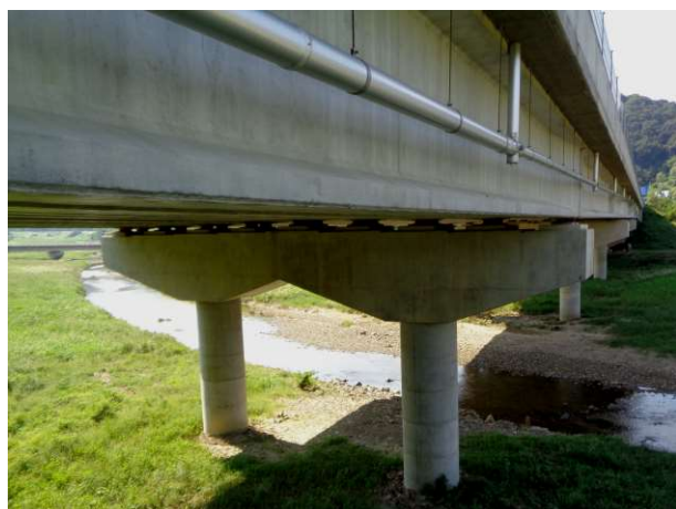
6공구 창기교 (6공구)
