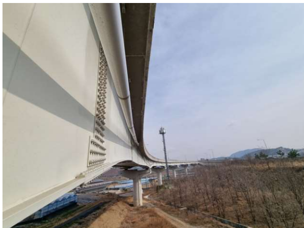
10공구 영천JCT Ramp-A교(10공구)
