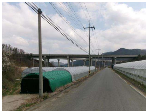
5공구 내리교 (5공구)
