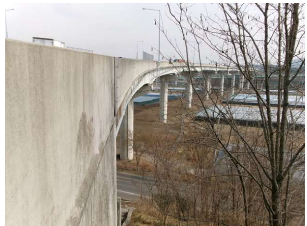
10공구 영천JCT Ramp-B교(10공구)
