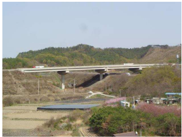
9공구 암기교 (9공구)
