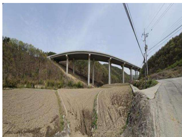
4공구 산호교 (4공구)
