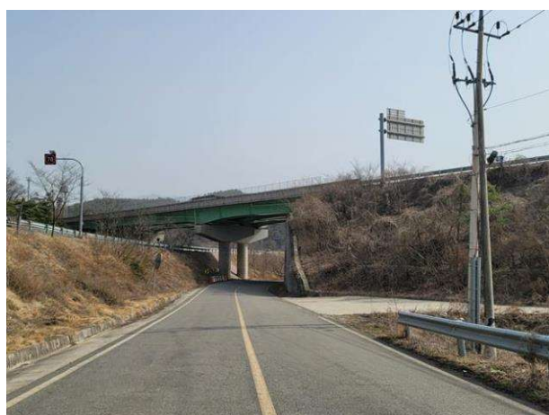
6공구 가호교 (6공구)
