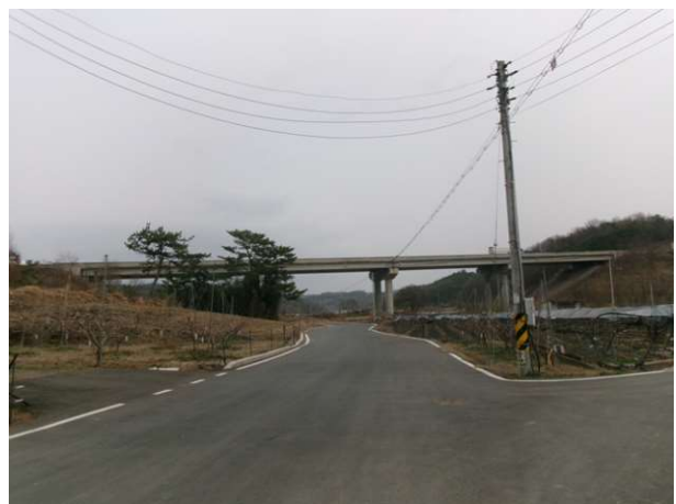
9공구 도림천교 (9공구)
