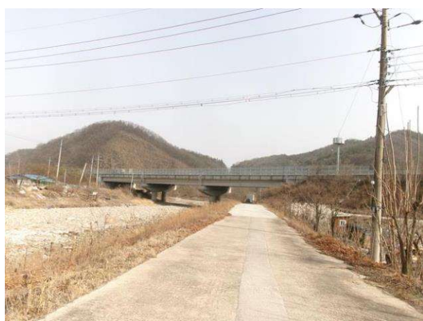
7공구 배골교 (7공구)
