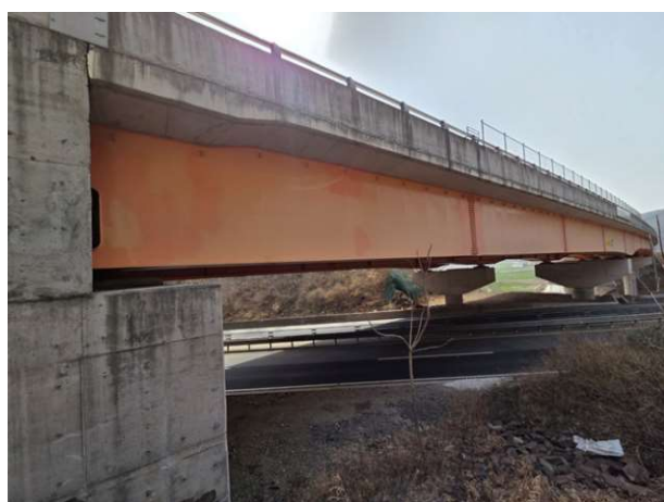
7공구 화남교 (7공구)
