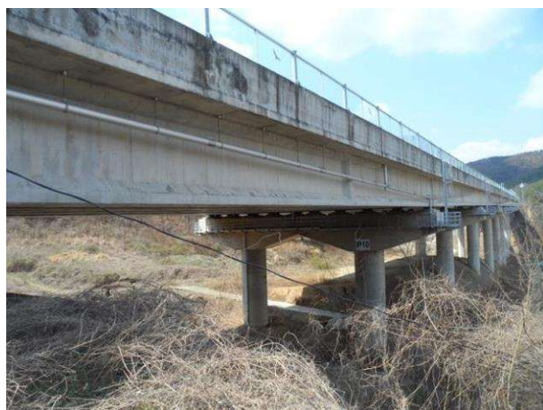
5공구 오로교 (5공구)
